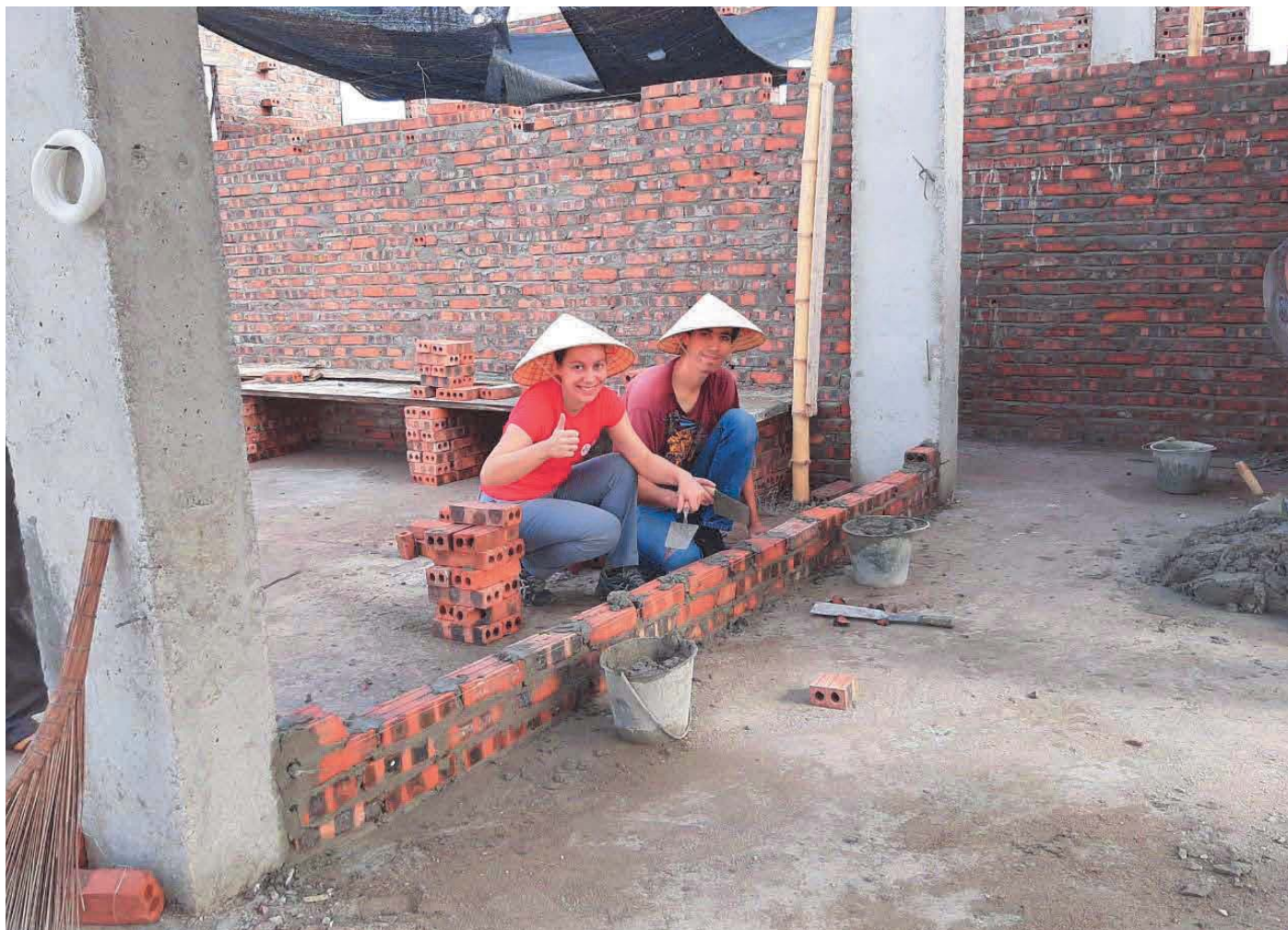
En pleine action, au démarrage d'un mur! Vous remarquerez l'usage du casque local ; quant au reste des EPI (gants, lunettes, chaussures de sécurité,...)
